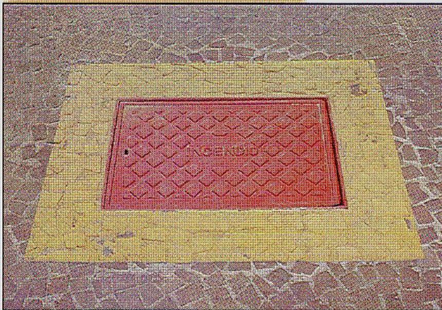
**Fig. 6.17-A** - Tampa identificando registro de recalque (RR) pelas cores e inscrição.
